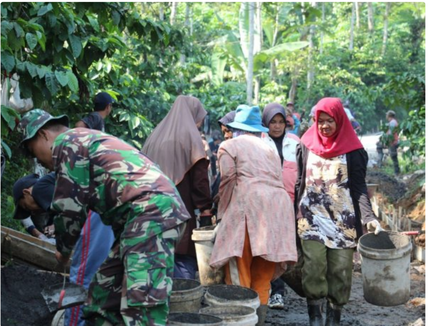
Ibu Ibu Bantu Percepat Pembangunan TMMD
